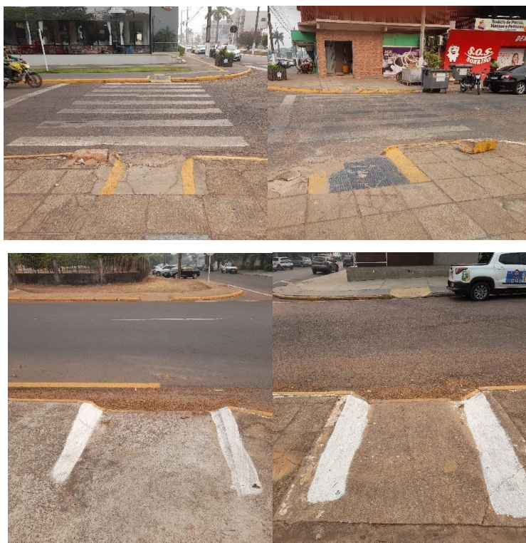
Figura 10 – Rebaixamentos danificados e travessias sem faixa de pedestre
