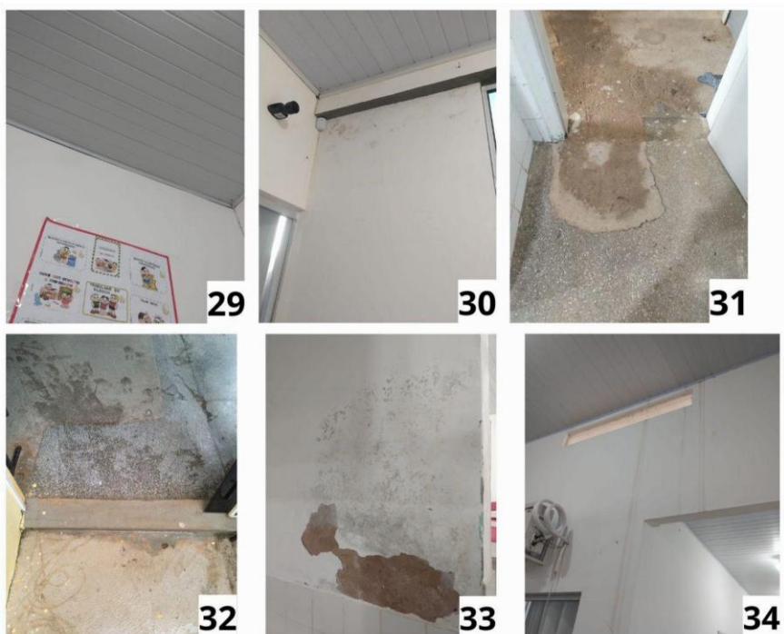
Figuras 29, 30, 31, 32, 33 e 34 – Infiltração, mofo, piso bruto e descascamento
