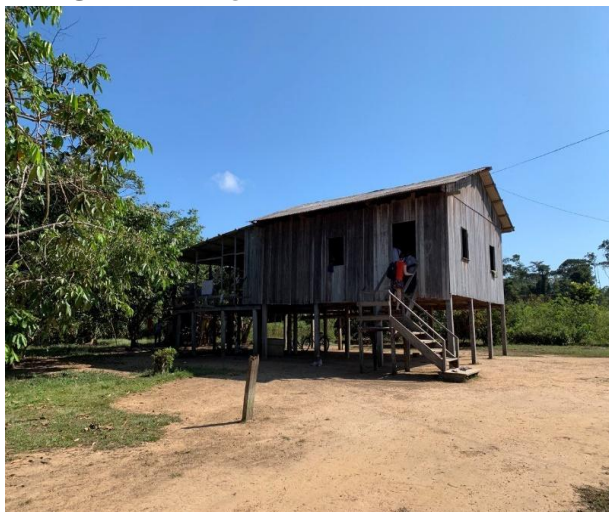
Figura 2 – Imagens da comunidade Km 45
